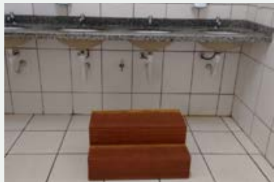
Plataforma de madeira para acesso ao lavatório
